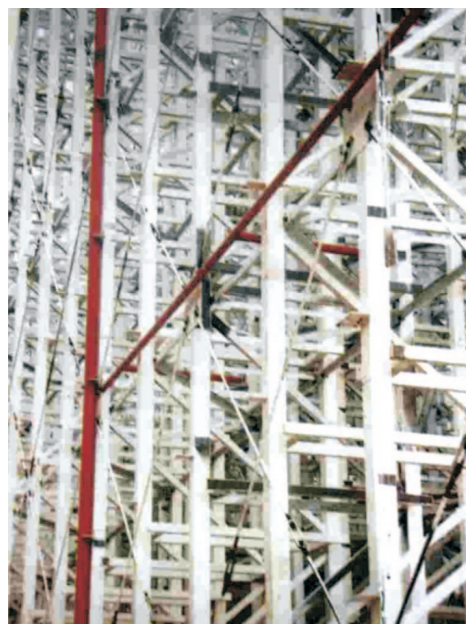
自動倉儲用管 Automatic Warehouse
